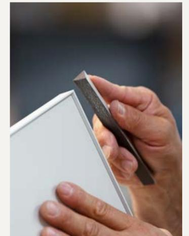
Detailarbeit bis zum Schluss. Das Entgraten der Ecken wird mittels Schleifstein von Hand vorgenommen – für ein optisch und haptisch perfektes Ergebnis.
